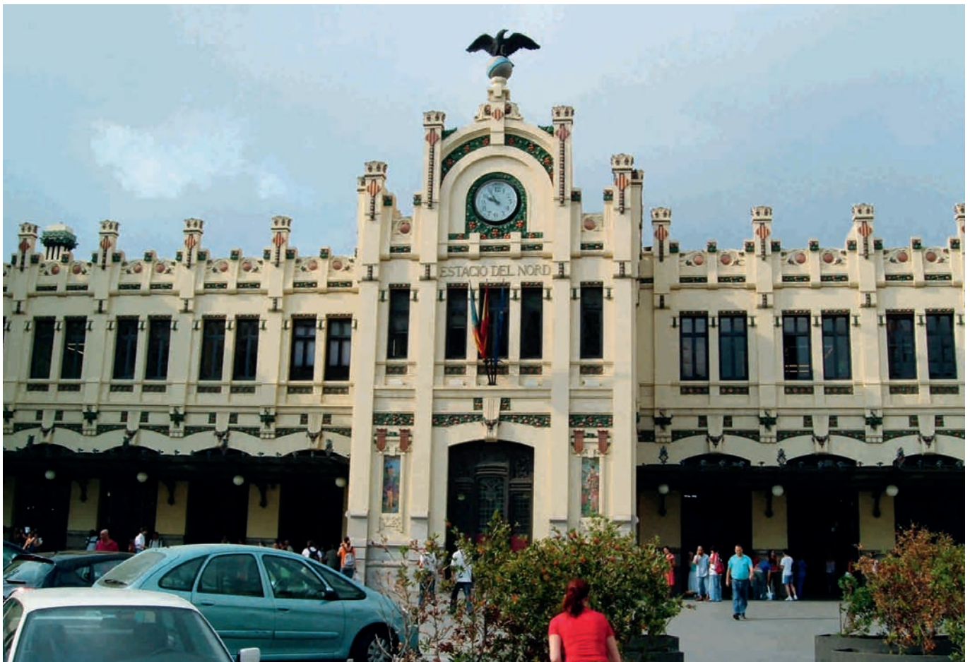
Estación del Norte de Valencia
