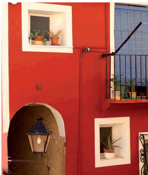
Rehabilitación en La Vila Joiosa
