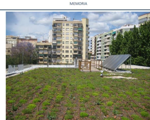
Figura 44. Cubierta vegetada en la azotea del colegio Gonzalbes Vera en el municipio de Xàtiva (Valencia). Proyecto AQUAVAL.
