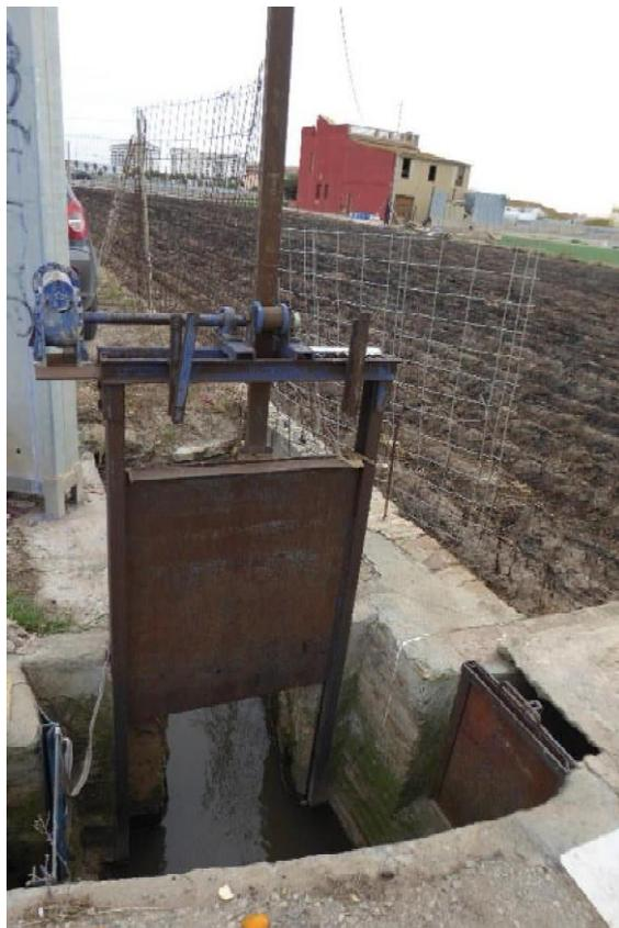
Ilustración 14. Detalle compuerta de riego, elemento característico de la zona
