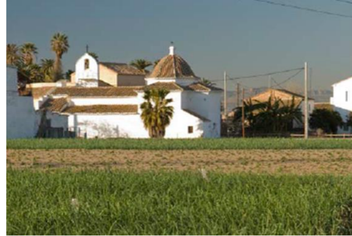
La ermita de Vera es uno de los elementos patrimoniales arquitectónicos de mayor relevancia de la huerta, y se encuentra en esta unidad de paisaje. Partida 'Masquefa'.
