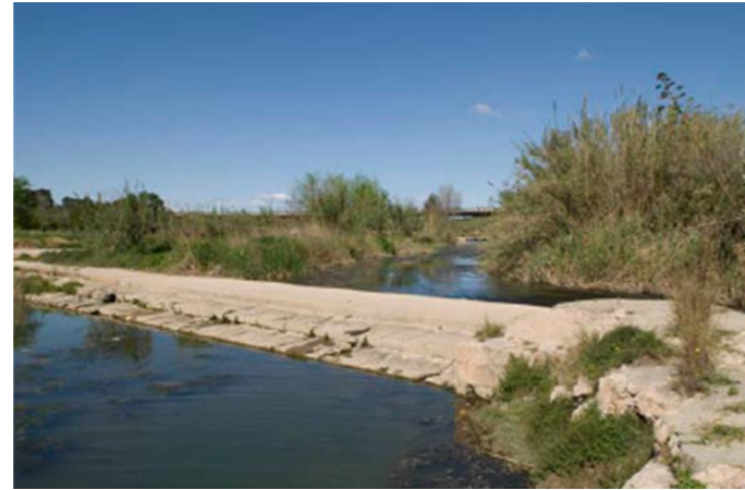
Azud sobre el río Turia para derivación del agua de riego de la huerta. Los azudes constituyen elementos patrimoniales hidráulicos de la Huerta de Valencia.
