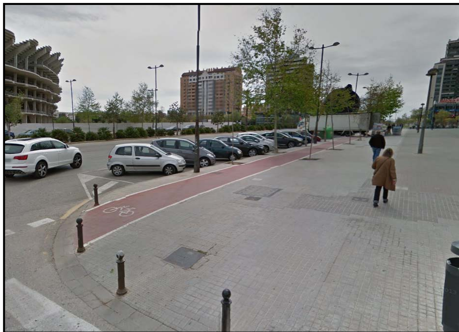
Vista del carril bici en la calle de La Safor.
