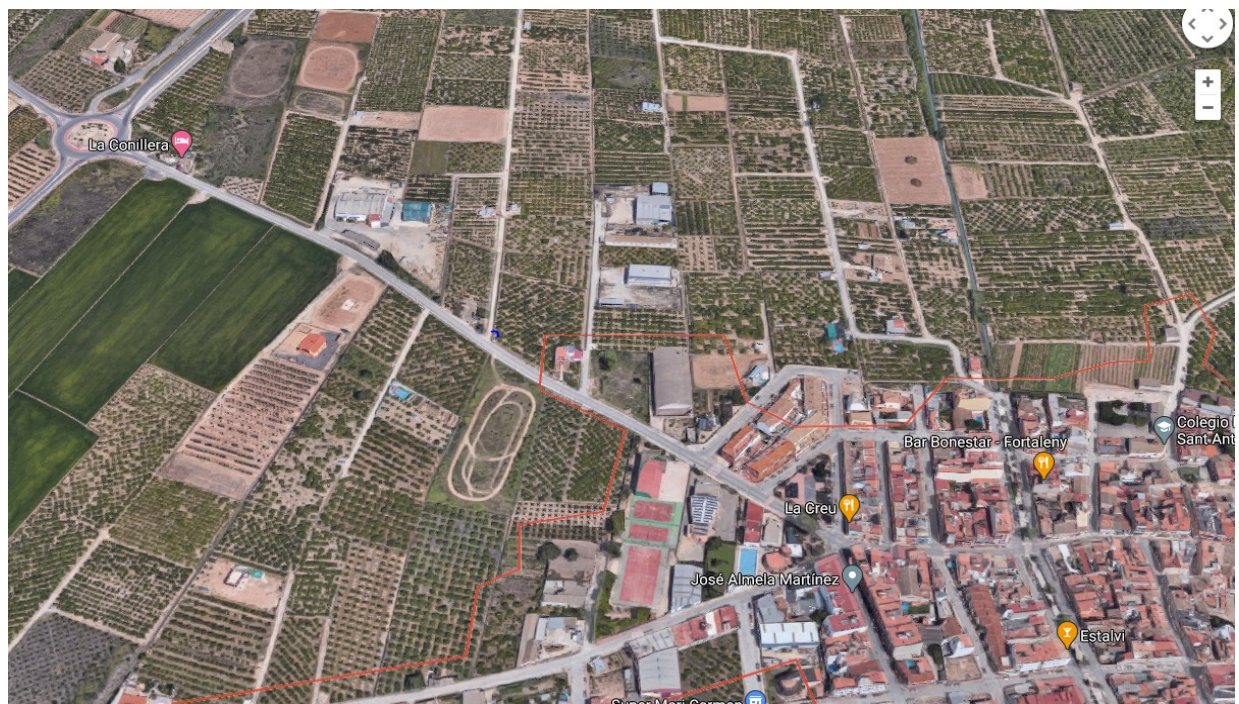
Imatge 2. Ortofoto de la zona nord-oest de Fortaleny. Es poden observar les naus industrials existents en l'àmbit de SNUTI.
