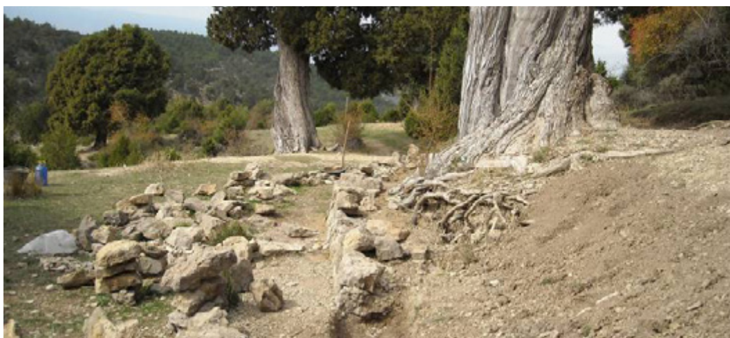
Construcción de muretes de contención sobre ejemplares longevos de Juniperus thurifera en la MRF Las Blancas (LIC Puebla de San Miguel). Fotografía: Archivo BN2000.
