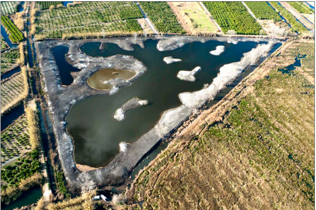
Imagen 16. Obras de remodelación de la reserva de Xeresa.
