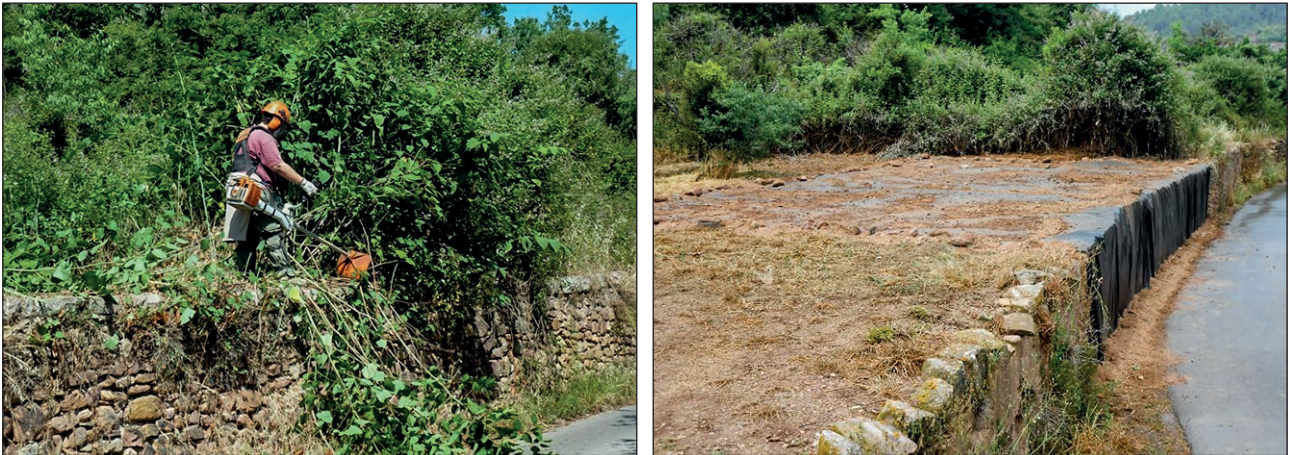
Figura 7. Desbroce de la viña del Tíbet previo a la colocación de coberturas (PN Espadán).
