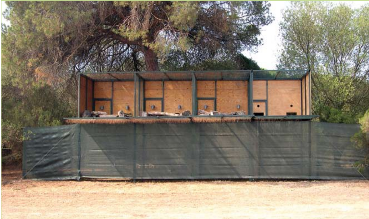
Vista de la torreta de hacking instalada en Marisma del Odiel con capacidad para 16 jóvenes (4 por cajón). Fuente: Fundación Migres.
