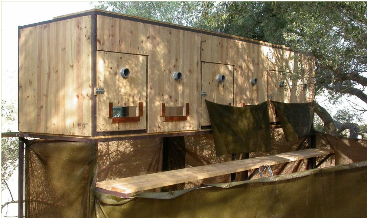
Vista posterior de la torreta de hacking . Obsérvense los cristales de una sola dirección, así como los tubos de PVC para proveer el alimento. Fuente: Fundación Migres.
