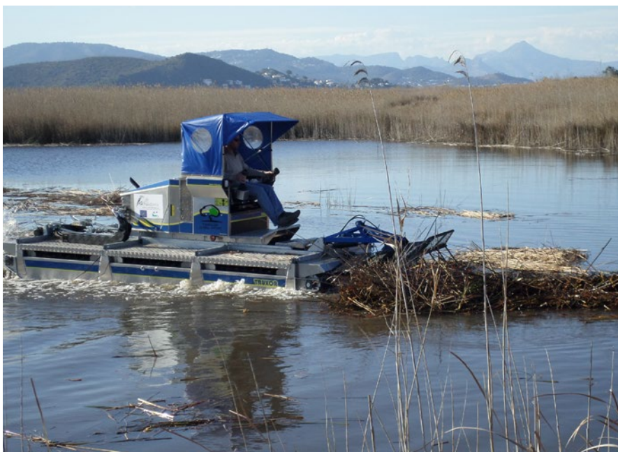
Trabajos de eliminaci3n de la vegetaci3n emergida en el marjal de Pego-Oliva. Fuente: Global Nature.
