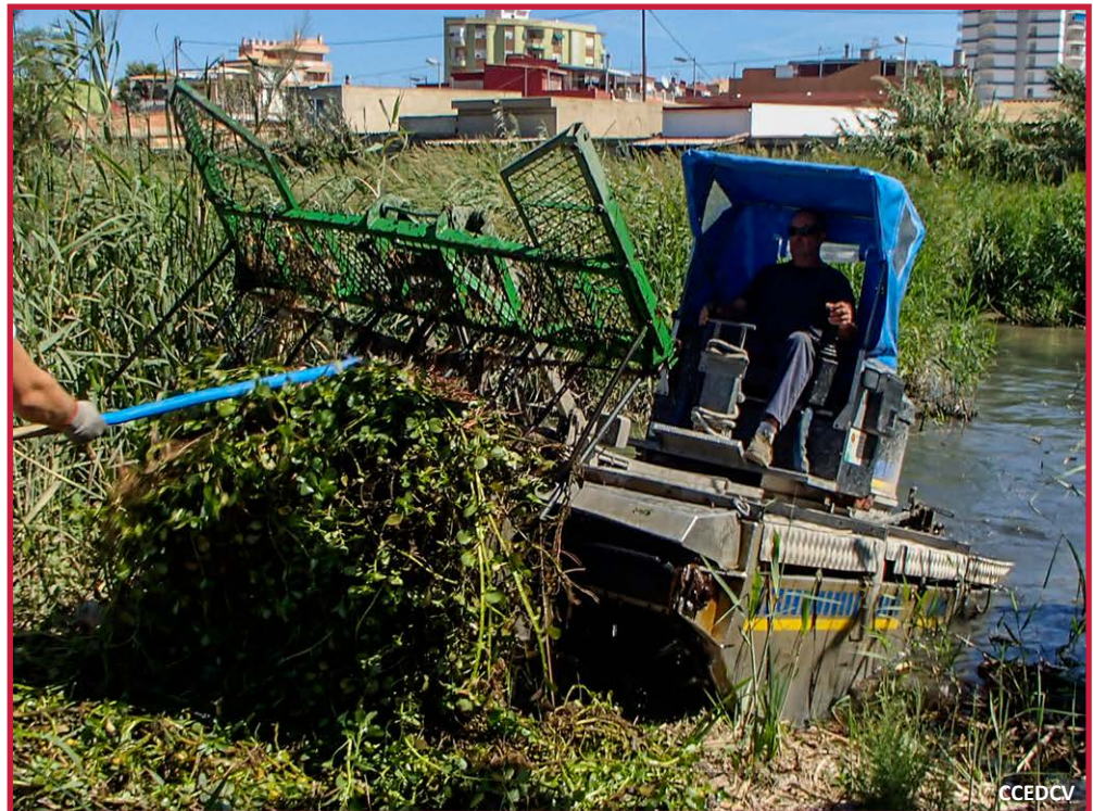
Trabajos de eliminación de Ludwigia grandiflora en el Carreró de Sueca.
