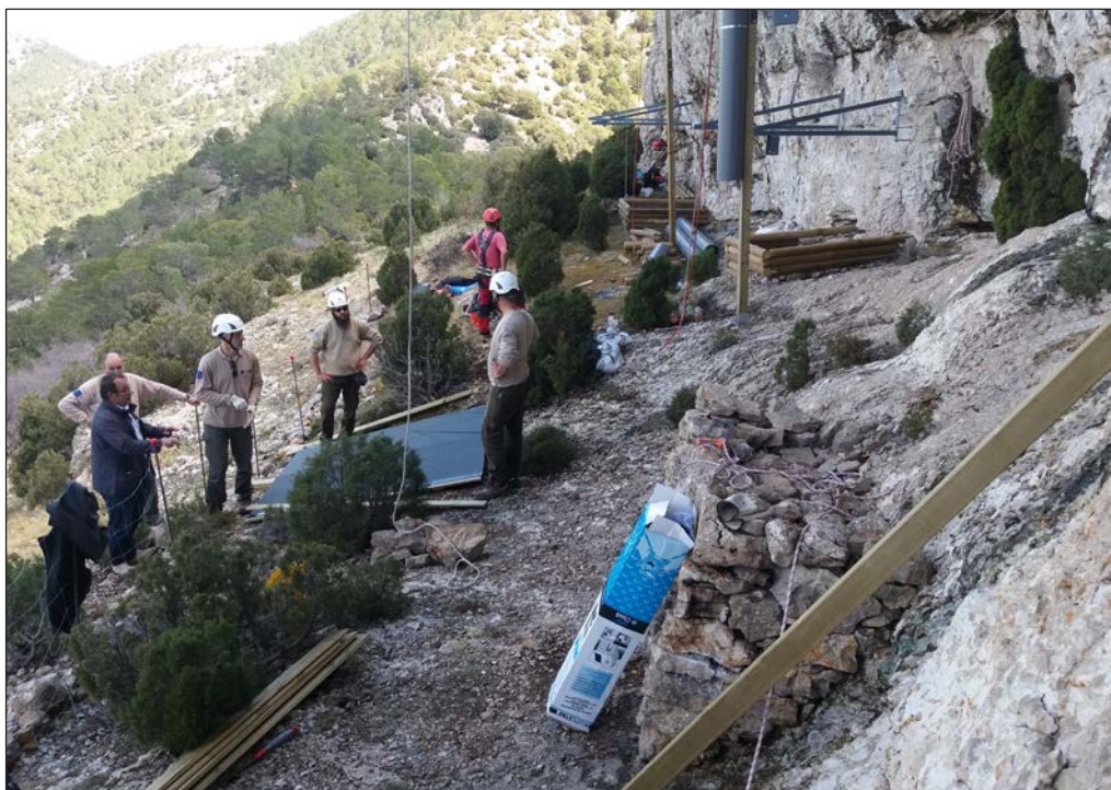
Construcción de las instalaciones de hacking en abril de 2018.
