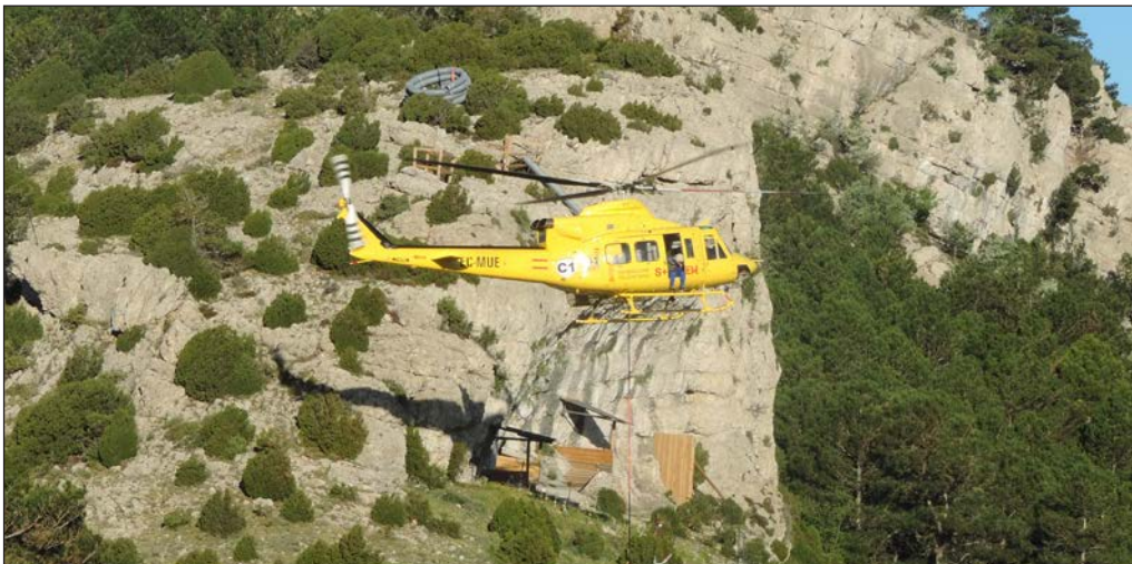
Tranporte en helicóptero del material utilizado en la construcción de las instalaciones.
