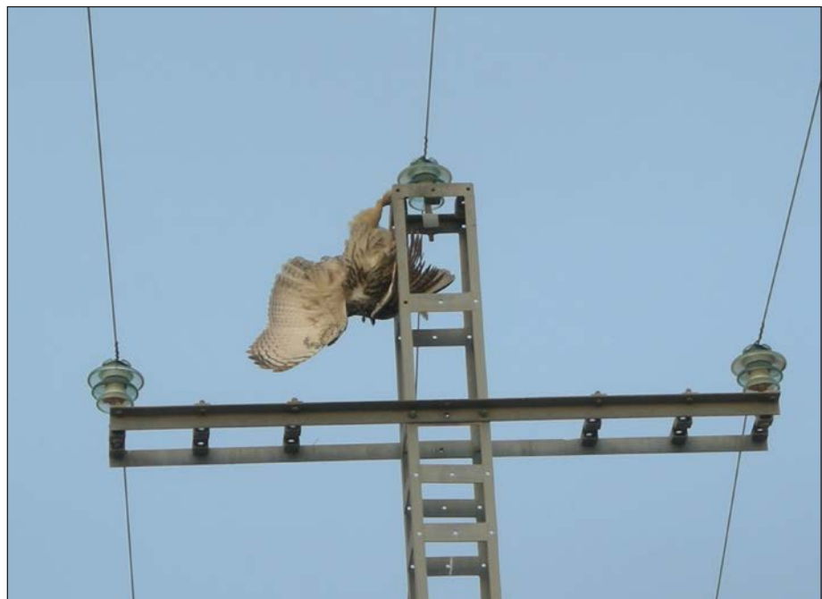
Detalle de la electrocución de un búho real. Autor: José Aragoneses/AAMM.
