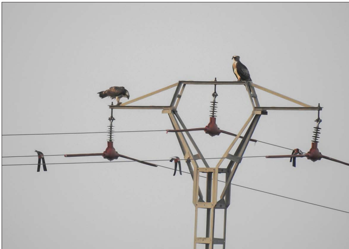
Águilas pescadoras posadas en la bóveda de un apoyo dotado con salvapájaros y dispositivos antielectrocución en el PN Marjal de Pego-Oliva. Autor: Itziar Colodro.
