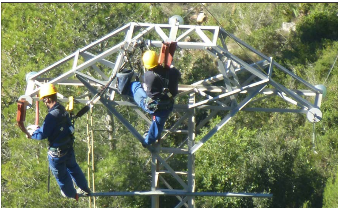
Trabajos de corrección en línea de la Generalitat de Mondúver. Autor: Elecnor.
