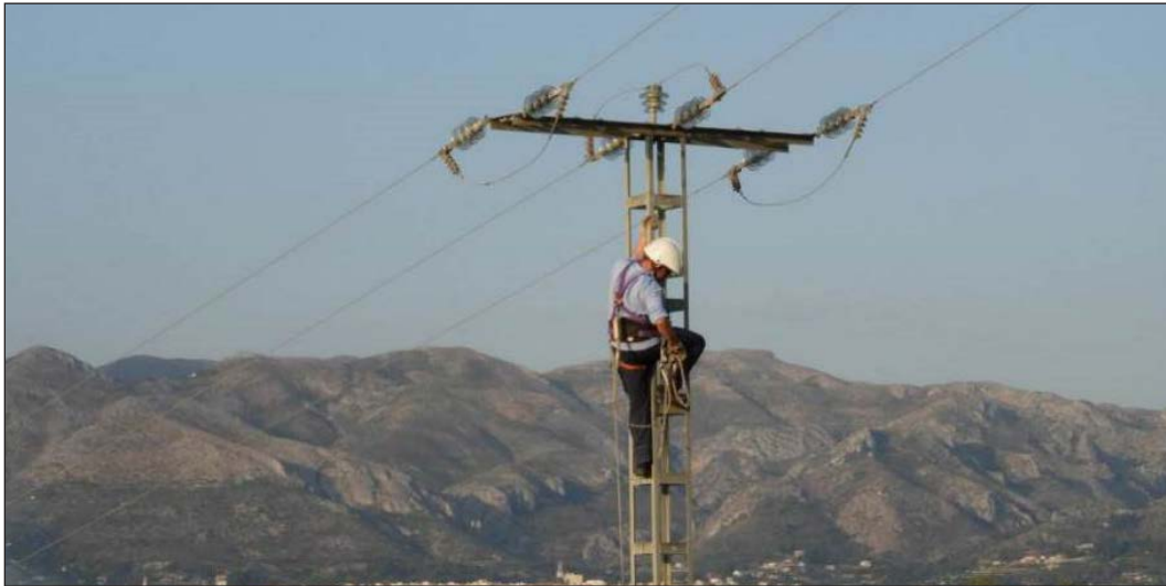
Desmontaje de la línea eléctrica abandonada. Autor: Vicente Sancho.
