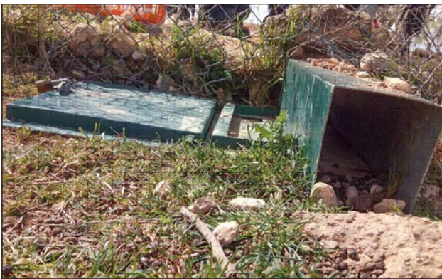
Trampa de conejos instalada en la valla de la plataforma del AVE
