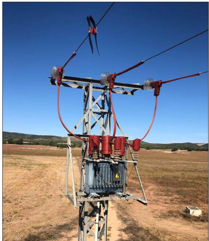
Adecuación de apoyos de propiedad particular en la ZEPA Meca-Mugrón-San Benito (Ayora) correspondiente a contrato de la Generalitat Valenciana. Foto: Pardo Valero S.L.
