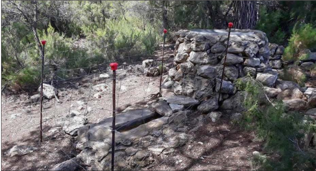
Abrevadero instalado en La Hunde
