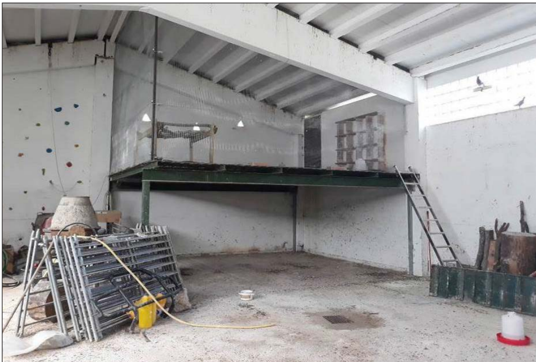
Aspecto general del palomar barrera en construcción, en la Casa Forestal de Jalance
