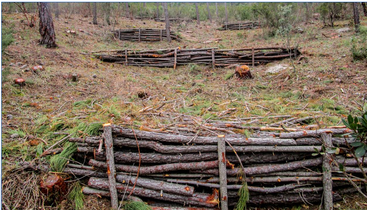
Fajinas de protección realizadas con los restos más voluminosos.
