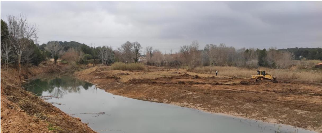
**Imagen 4:** Trabajos de distribución de restos de triturado y reperfilado en el río Túria (T.M. Manises) después del desbroce de caña y antes de la colocación de la cobertura opaca. Fuente: Ramón G. Pereira (17-1-2020).
