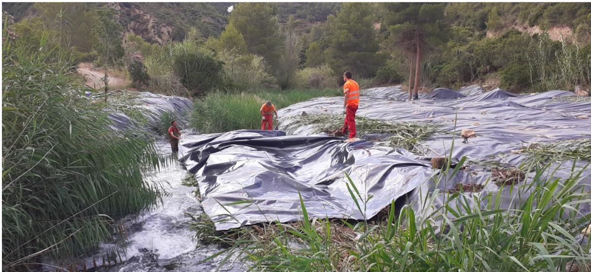
**Imagen 3:** Instalación de coberturas opacas en el río Reatillo. Fuente: Ramón G. Pereira
