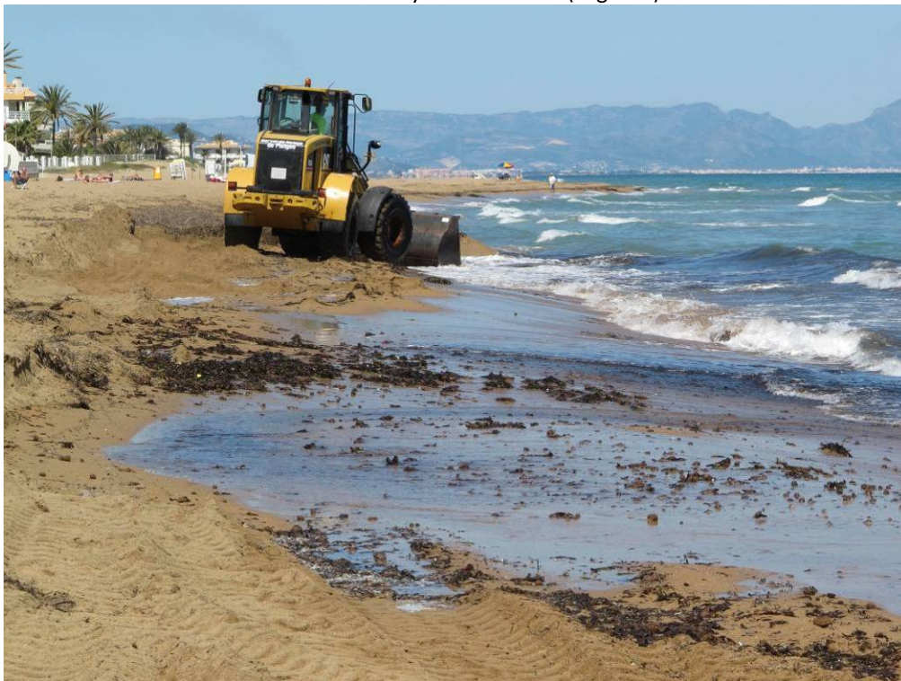
Imagen 8. Eliminación de restos mareales con maquinaria pesada durante la época de cría en Denia (Alicante). Los restos mareales, además de fuente de alimentación son utilizados frecuentemente como sustrato de nidificación.
