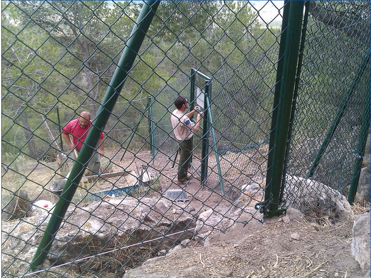
Foto 20. Cerramiento de cuevas para murciélagos (Sima Borreguillos, Salinas).
