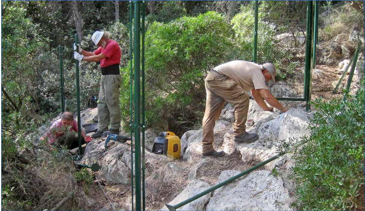
Foto 15. Colocación de vallado en cueva ZEC (Cova Xurra, Gandia).
