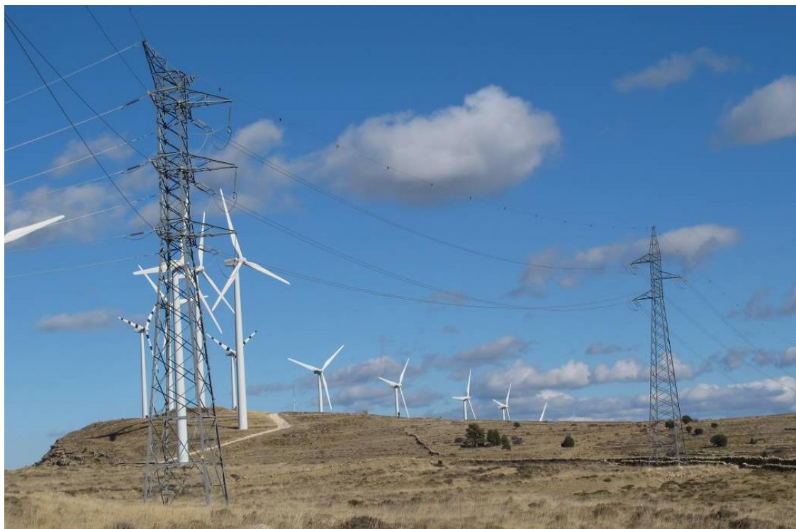
Fotografía 10.- Apoyos de tendidos eléctrico con medidas de corrección instaladas para minimizar el riesgo de electrocución (arriba izquierda Valdelinares; arriba centro Pitarque; ambos en Teruel). Apoyo peligroso sin medidas de corrección (arriba derecha, Fredes; Castellón) y línea de evacuación de parques eólicos en el municipio de Villafranca del Cid (abajo; Castellón) (Fotos: Pascual López)
