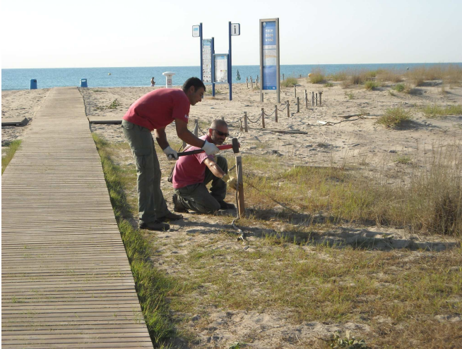
Colocación vallado blando en el Arenal de Borriana
