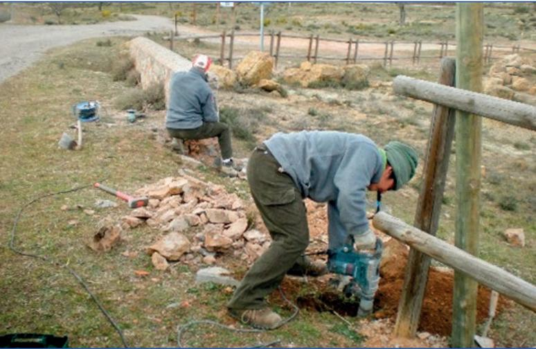
**Imagen 10.** Trabajos de reparación de la talanquera perimetral en la RF Balsa Silvestre (Alcublas, Valencia).
