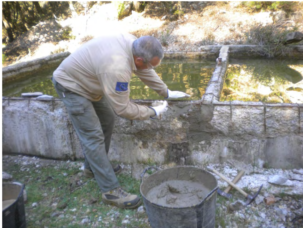
Figura 9. Treballs en microreserves de flora. A la part superior, desbrossament de vegetació per a reduir competència amb l'espècie Epipactis fageticola a la MRF Río Bohígues (Ademuz). A la part inferior, restauració d'abeurador a la MRF Font del Teixet (Morella).
