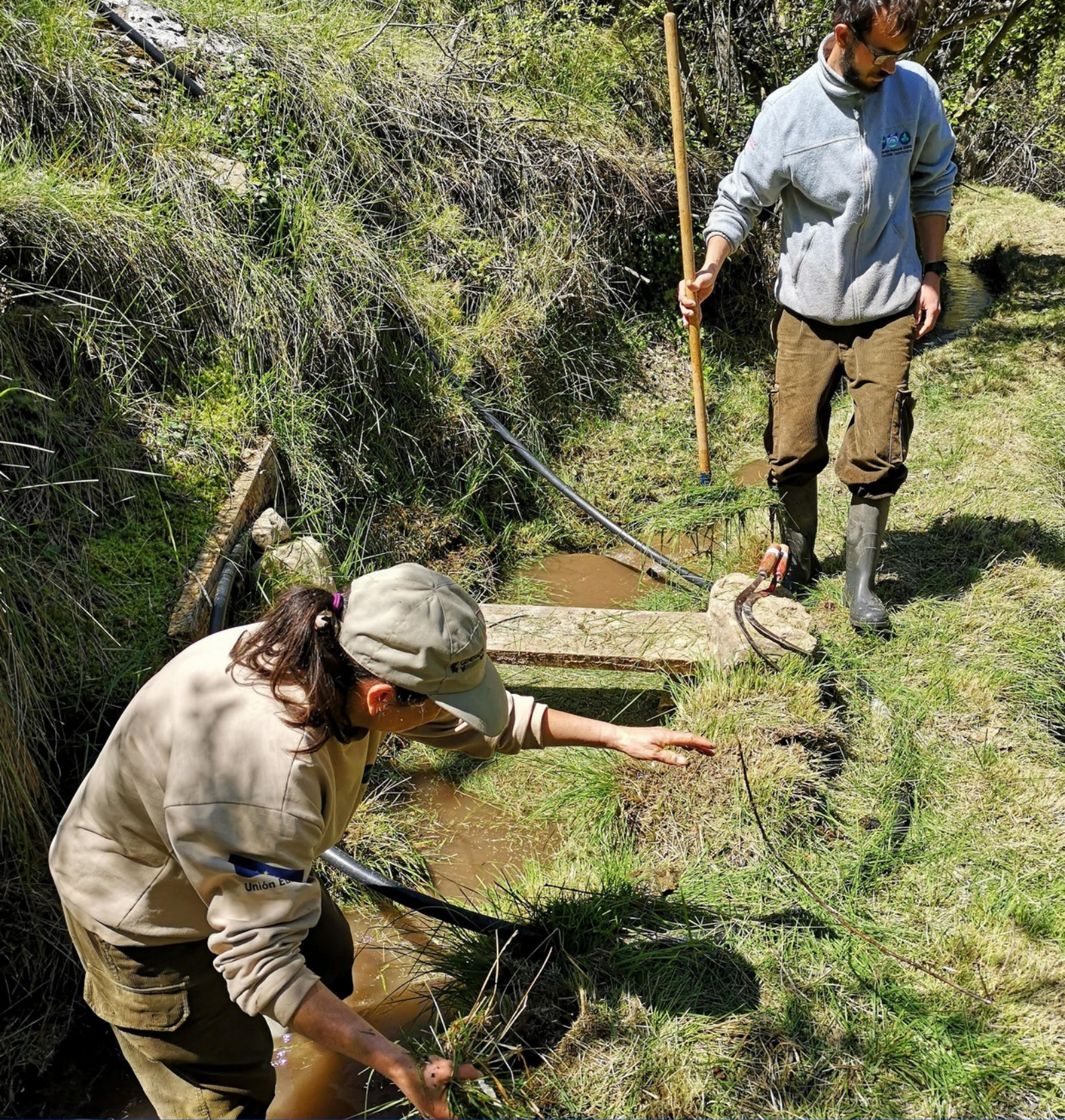
Actuació de restauració de la tova del Carbo (Hàbitat 7220) (Villahermosa del Río)
