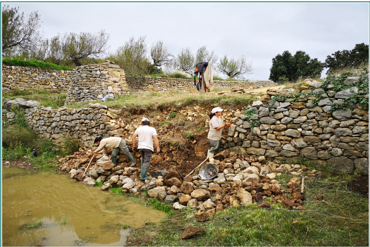
Imatge 3. Restauració de mur de pedra seca a la RF Pou del Rollo (Ares del Maestrat).
