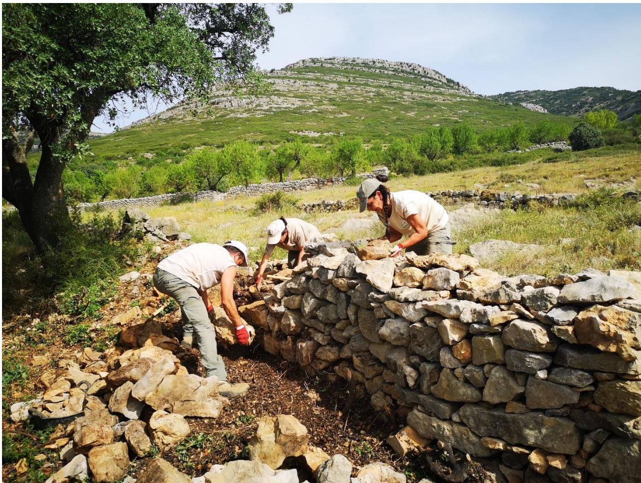
Imatge 5. Manteniment i construcció de mur de pedra a la RF Pou de Rollo (Ares del Maestrat)
