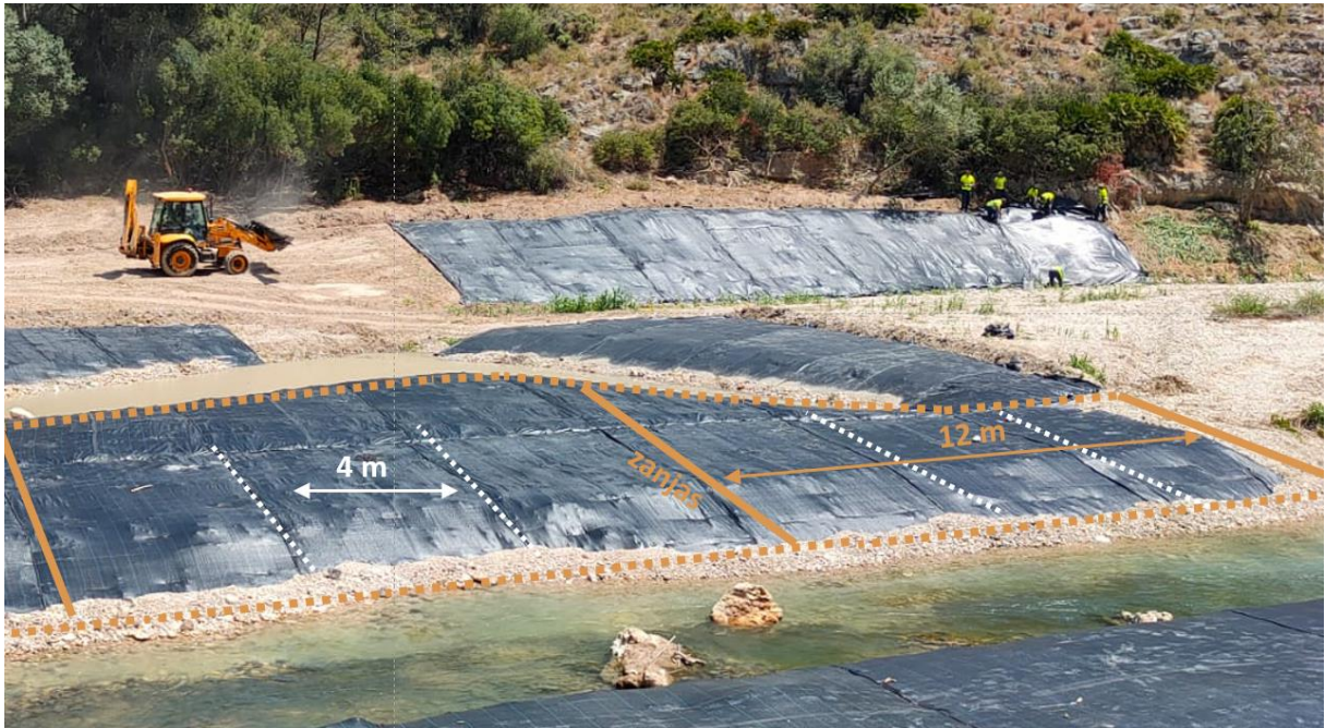
Imagen 8: Ejemplo de instalación de zanjas para la sujeción de las coberturas opacas en el río Albaida. Leyenda: las líneas discontinuas blancas representan las zonas de solape entre coberturas y fijadas con grapas metálicas, las líneas discontinuas marrones las zanjas perimetrales y las líneas continuas marrones las zanjas transversales. Fuente: Ramón G. Pereira.
