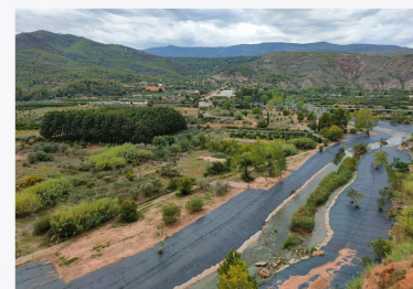
Coberturas opacas instaladas en Gestalgar
