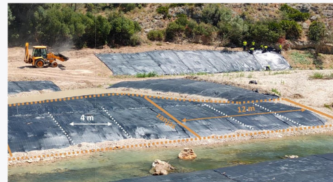
Instalación de coberturas opacas en el río Albaladea
