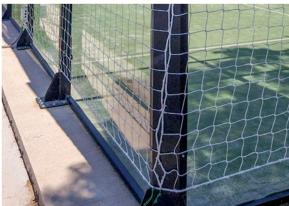
Detalle de la unión de dos tramos de red mediante un cordón continuo de nylon que las anuda entre sí cada 10 cm
