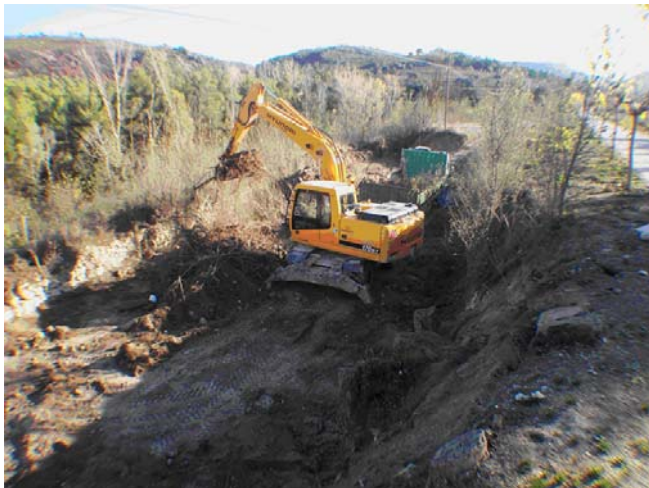
Figura 17: Recuperación de la balsa de la Masia Ull de Canals (Banyeres). Izquierda: Retirada de la tierra acumulada en la balsa. Derecha: Estado actual de la balsa, con el agua acumulada en la cubeta.
