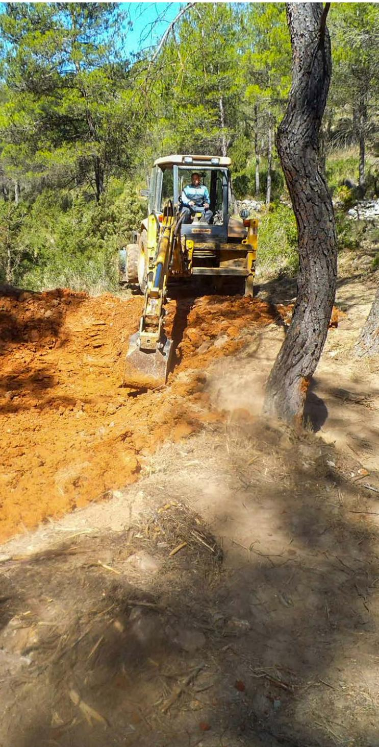
Creación de un nuevo punto de agua mediante excavación de su cubeta con retroexcavadora en el LIC Sierra de Malacara, Requena (Valencia). BRIGADAS NATURA 2000.
