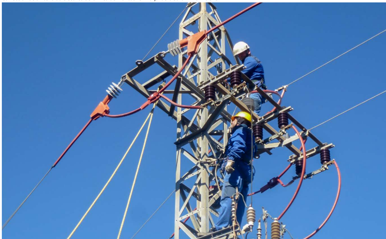
Corrección de un tendido eléctrico de la línea de Montdúver-Marjal de la Safor. ARCHIVO SVS.
