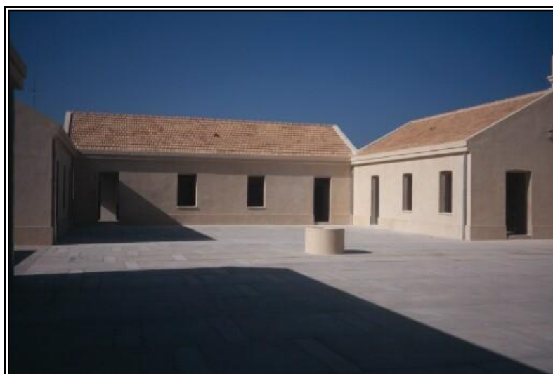
Figura 10. Patio interior del CIMAR. Aula de prácticas (derecha), laboratorios de investigación (centro) y biblioteca-despachos-(derecha)
