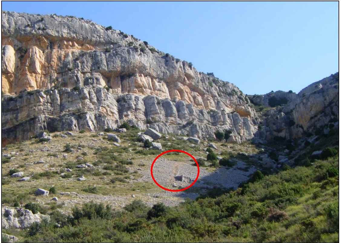
▲ En la imagen se señala el tramo del sendero que discurre por zona con elevado riesgo de erosión.
