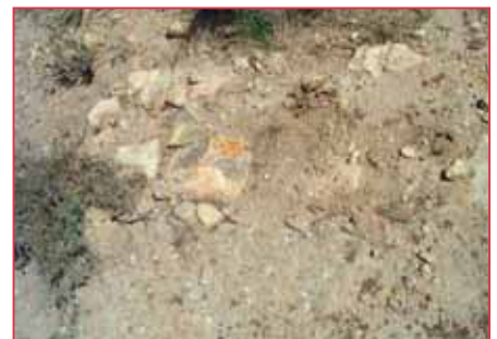
Tramo de muro.
