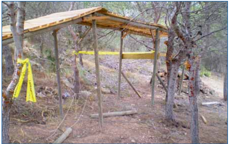
Ramas arrancadas y material robado de nuestras instalaciones para construir obstáculos en el circuito ilegal. (A.E.)
