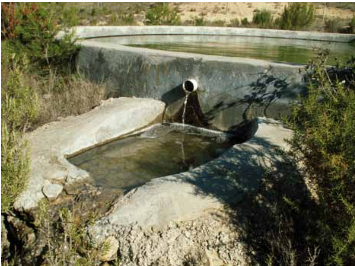
Pequeña alberca anexa a un depósito de incendios. Fuente del Chorrillo (Jarafuel).
