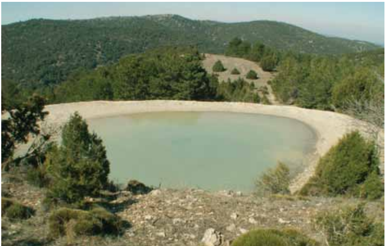
Navajo Monreal (El Toro). Parte del sedimento de la cubeta es extraído para aumentar la mota perimetral.
