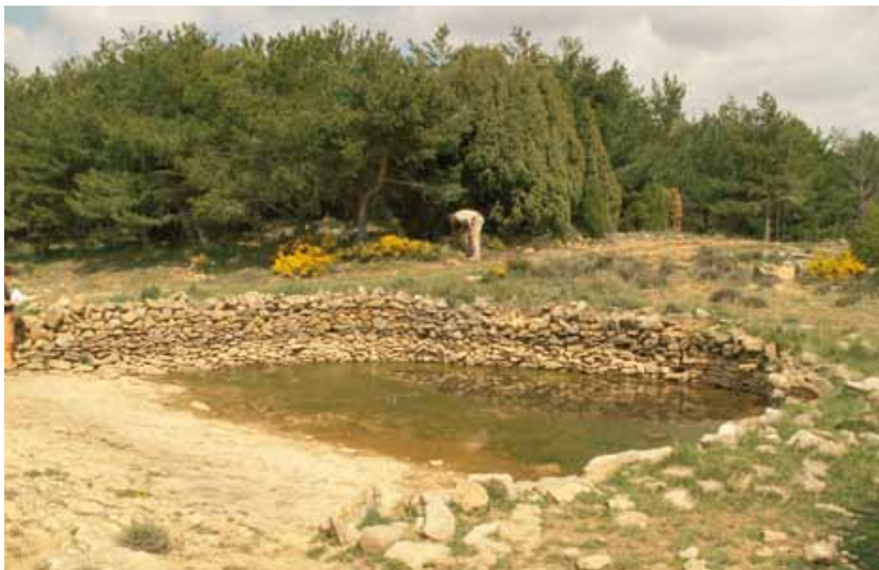
Bassa del Mas de Cambra (Vistabella del Maestrat). Charca abrevadero con parte de la orilla sujeta por muros de piedra seca.
