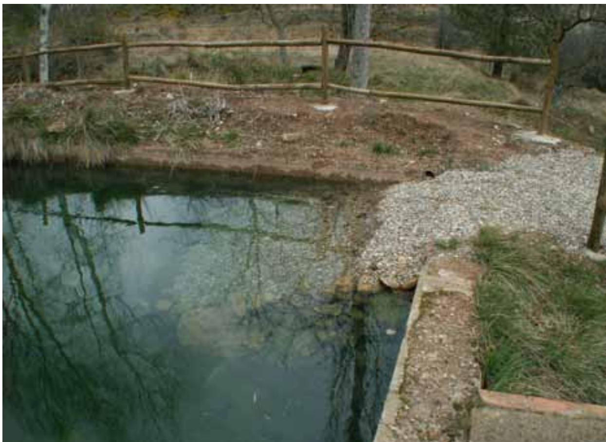
Balsa de Villar de Olmos (Requena). En uno de sus márgenes se instaló una rampa de mampostería, recubierta de tierra y piedras.
