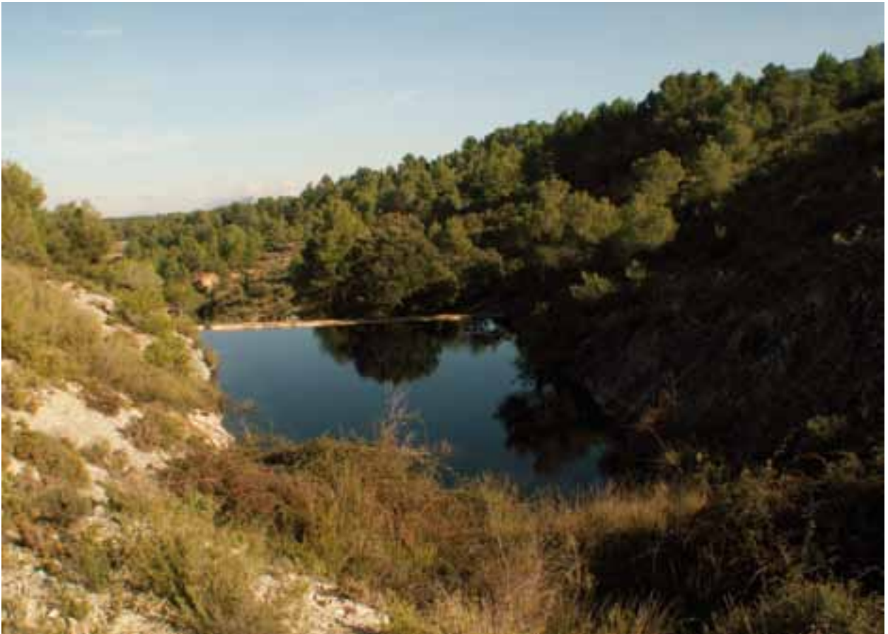
El mismo paraje una vez arregladas las grietas y recuperada su funcionalidad.
