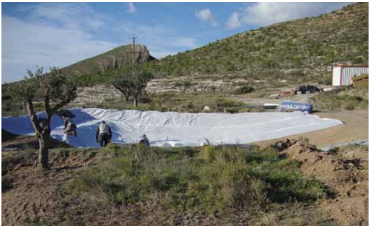
Colocación una lámina de geotextil previa a la colocación de la lámina impermeable. [Foto: José Antonio Reyes/Asociación Hyla]
