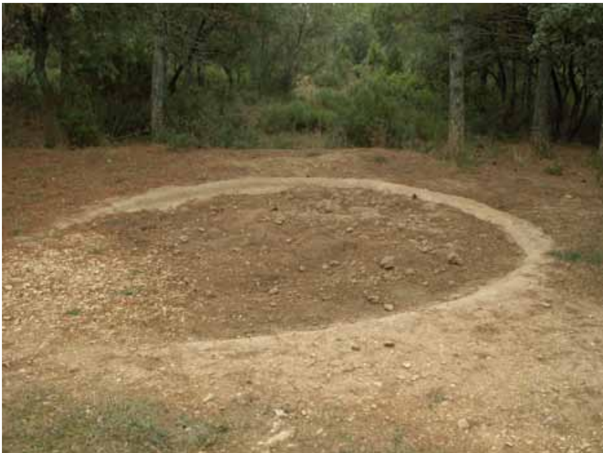
La Balsa Gaspar (La Yesa) es una pequeña charca cinegética totalmente colmatada por los sedimentos.
