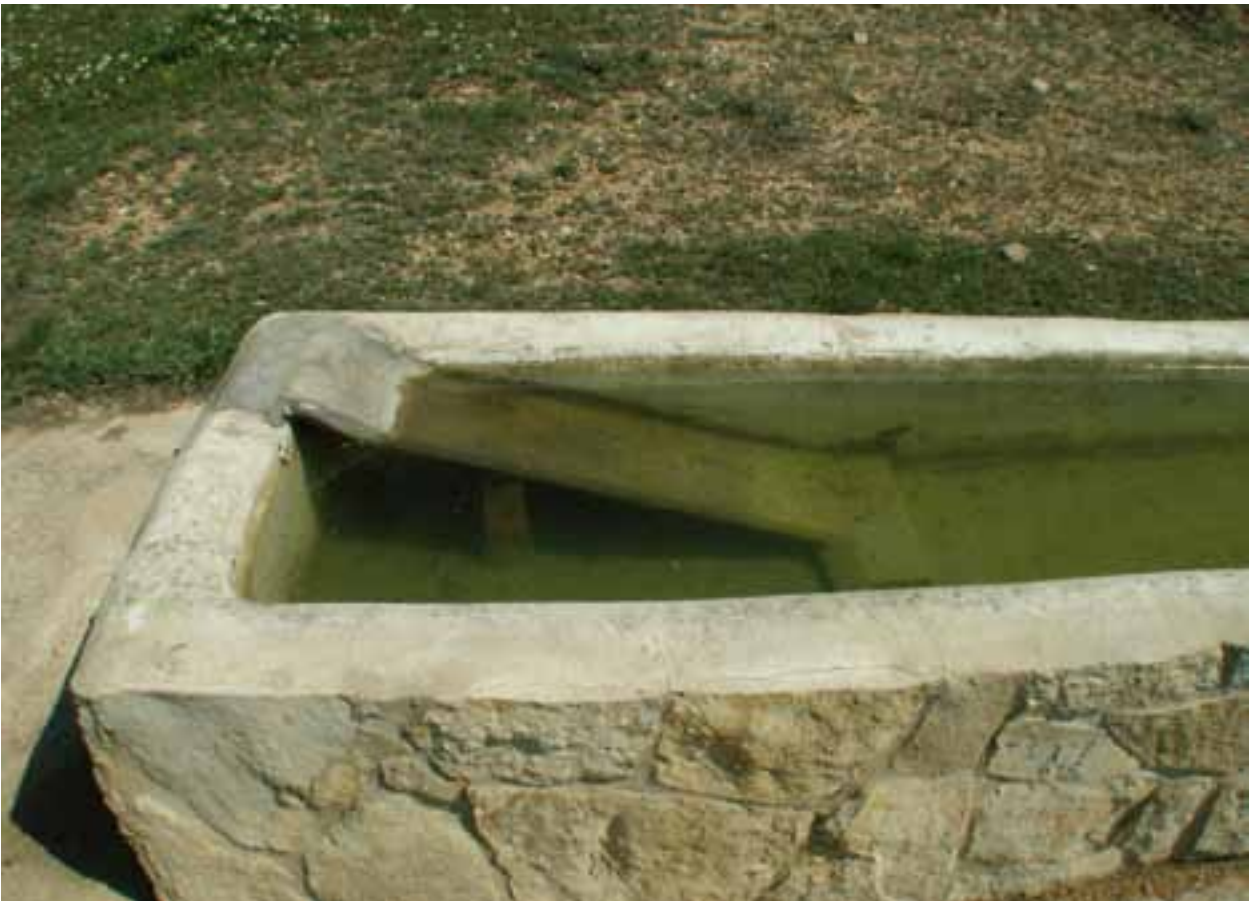
Fuente de la Oliva (Villargordo del Cabriel). Instalación de una pequeña rampa de escape en el interior de un abrevadero.
