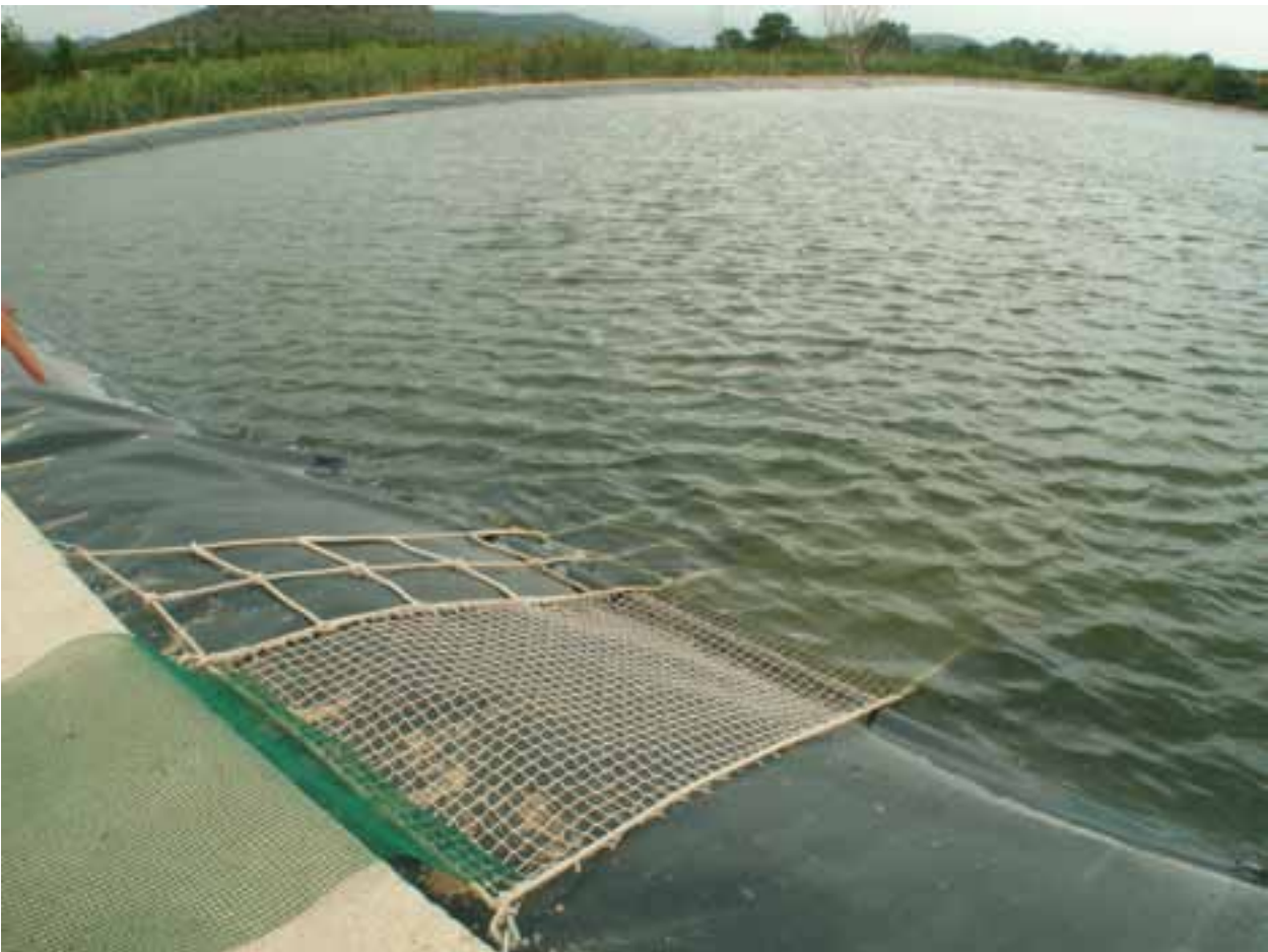
Balsa de riego en Turís, con una malla provisional destinada a facilitar la salida de la fauna.
