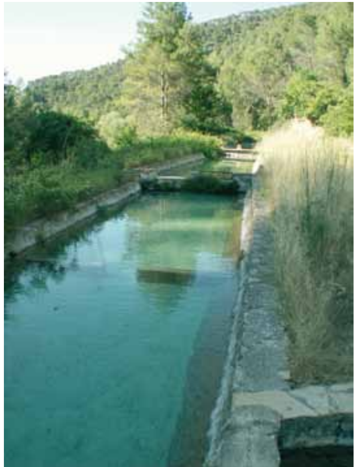
En el Manantial de los Baños (Titaguas) existen varias balsas cuyo origen se encontraba en un antiguo molino, posteriormente adaptado como piscifactoría.
