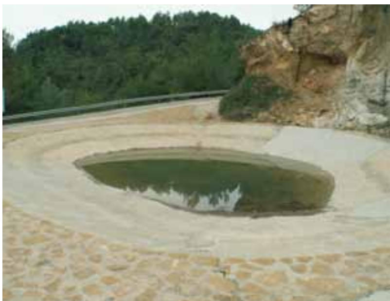
Navajo de Matet: Antiguo navajo del Parque Natural de la Sierra d'Espadà totalmente transformado y cementado tras una ampliación de la carretera.
