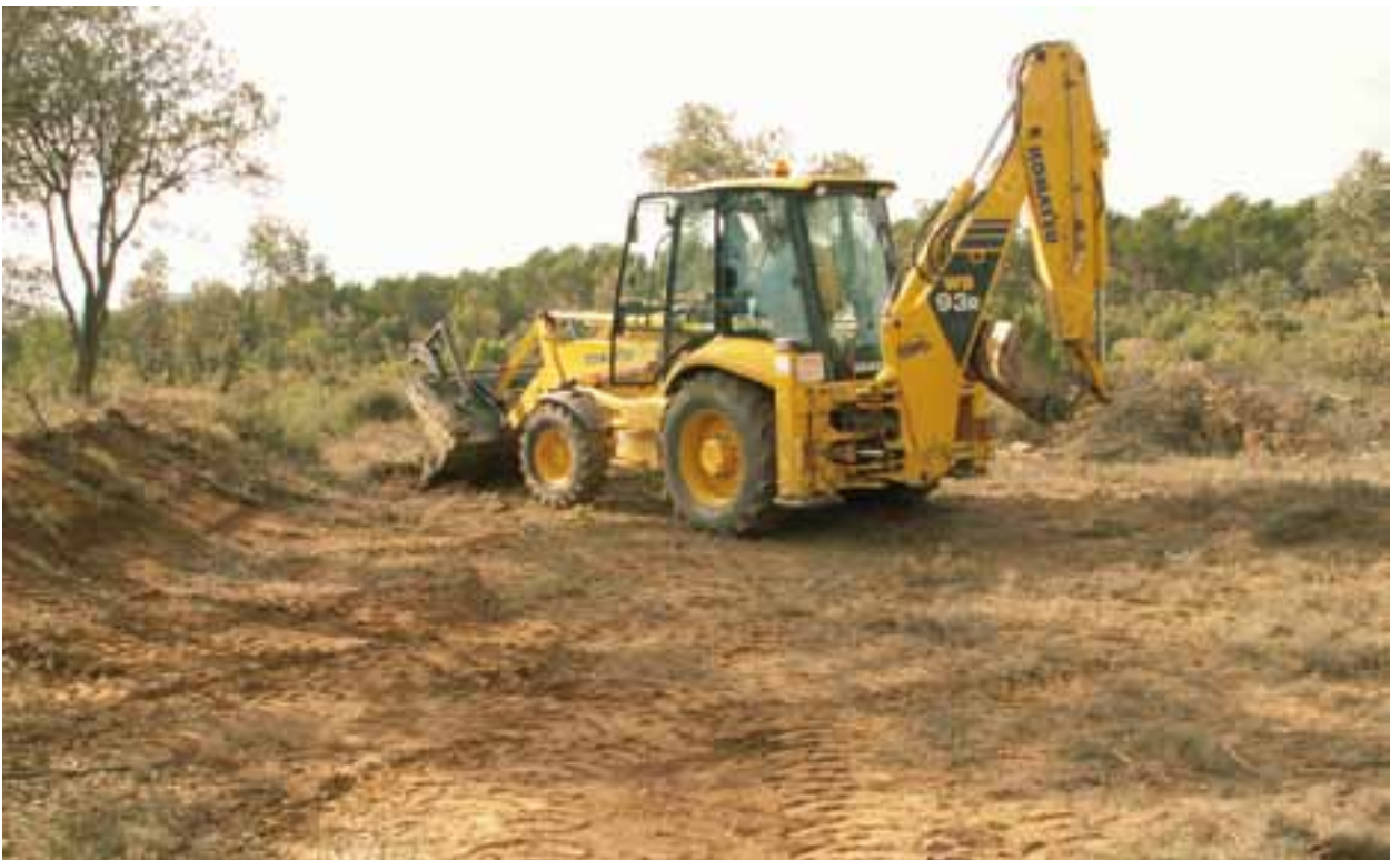
Excavación de una charca mediante retroexcavadora mixta.
